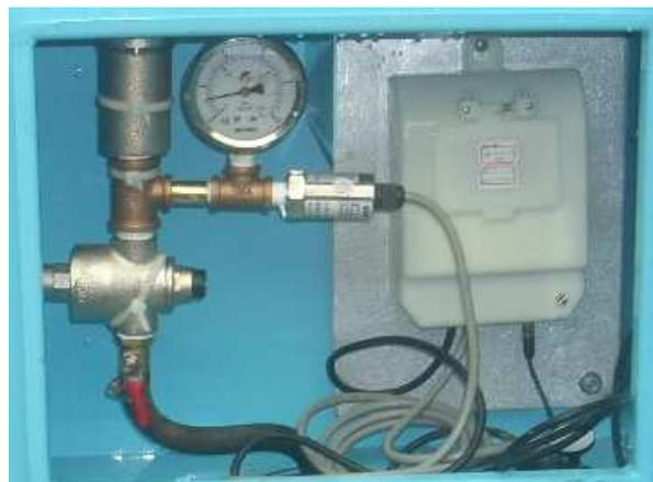
圖 5 橫軸奧多曼式水量計傳訊設備圖
