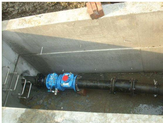
圖 4- 自備電源 C 級橫軸奧多曼式電子水量計現場建置圖
