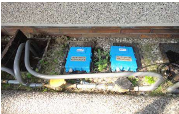
圖 1 水量計 B 及 C 級現場安裝圖
