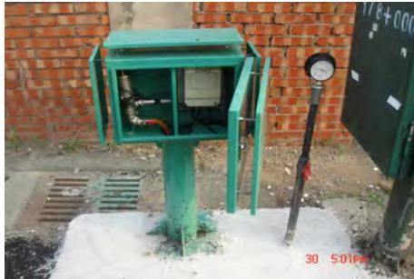
圖 3.3 傳訊記錄器現場圖，自備電源、IP67 防護等級
