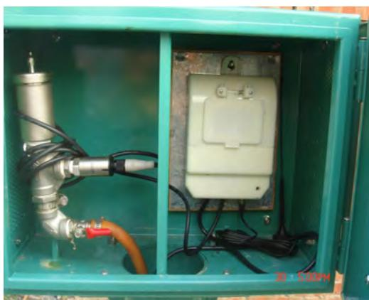
圖 3.6 IP67 防護等級的壓力檢知器裝置於儀表箱內
