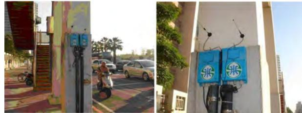
圖 3.4 自備電源之傳訊器具 IP67 防護直接設置於室外的天橋橋墩與騎樓樑柱上
