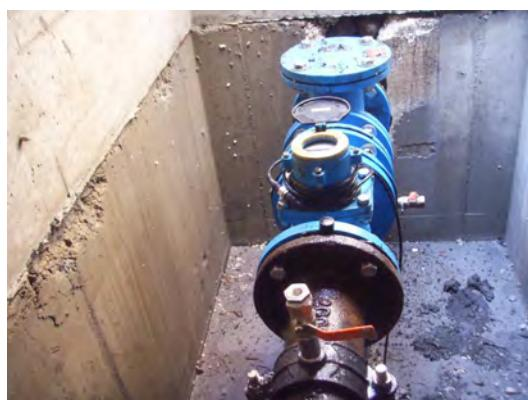
圖 3.2 橫軸奧多曼式 C 級水量計現場圖 – 自備電源、IP68 防水等級
