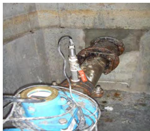
圖 3.7 無法設置儀表箱地點以 IP68 防護等級的壓力檢知器直接安裝於窨井內
