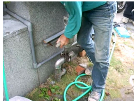
圖 4.2 分水鞍上壓力傳感器插入孔鑽孔作業
