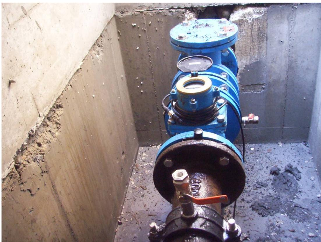
圖 2 橫軸奧多曼式C級水量計現場圖 - 自備電源、IP68 防水等級
