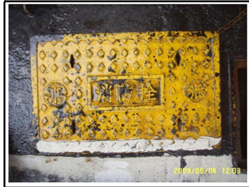
圖 5 路面窰井設置以IP68 之C級水表與傳訊記錄器並置入消防栓盒內
