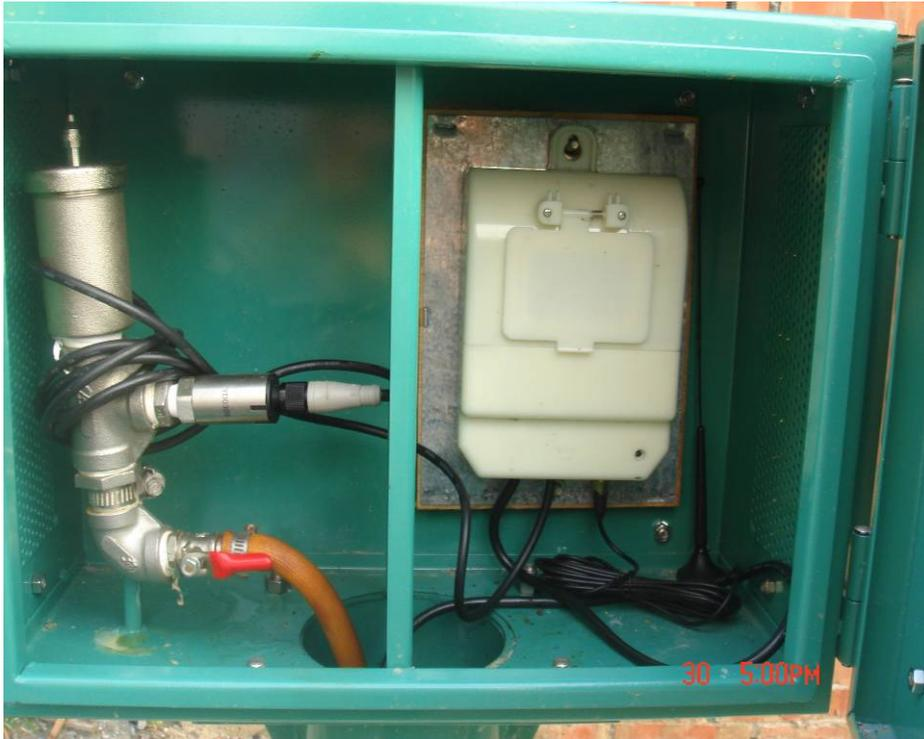
圖 6 IP67 防護等級的壓力檢知器裝置於儀表箱內
