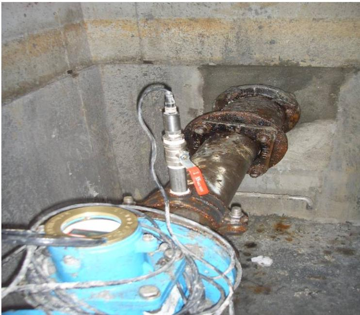
圖 7 無法設置儀表箱地點以IP68 防護等級的壓力檢知器直接安裝於窰井內
